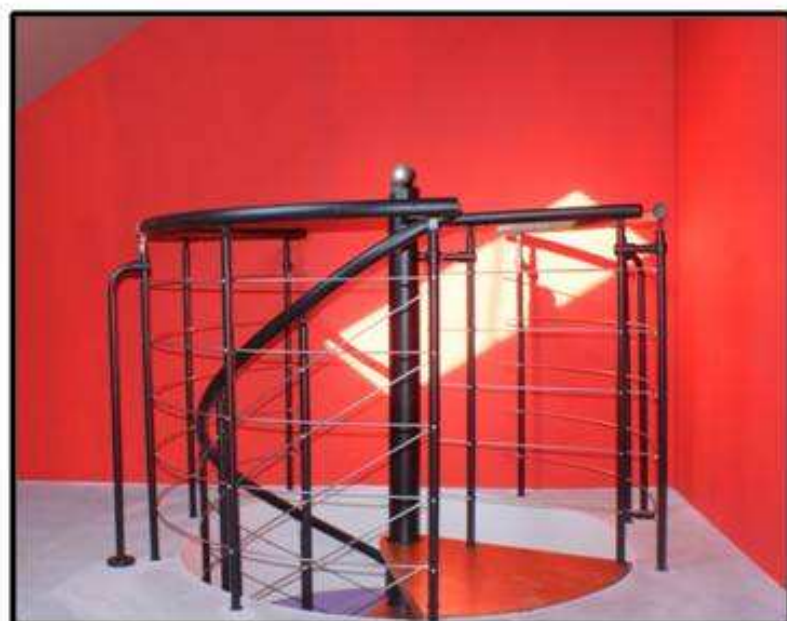
Balustrada ochronna schody przylegające do antresoli
