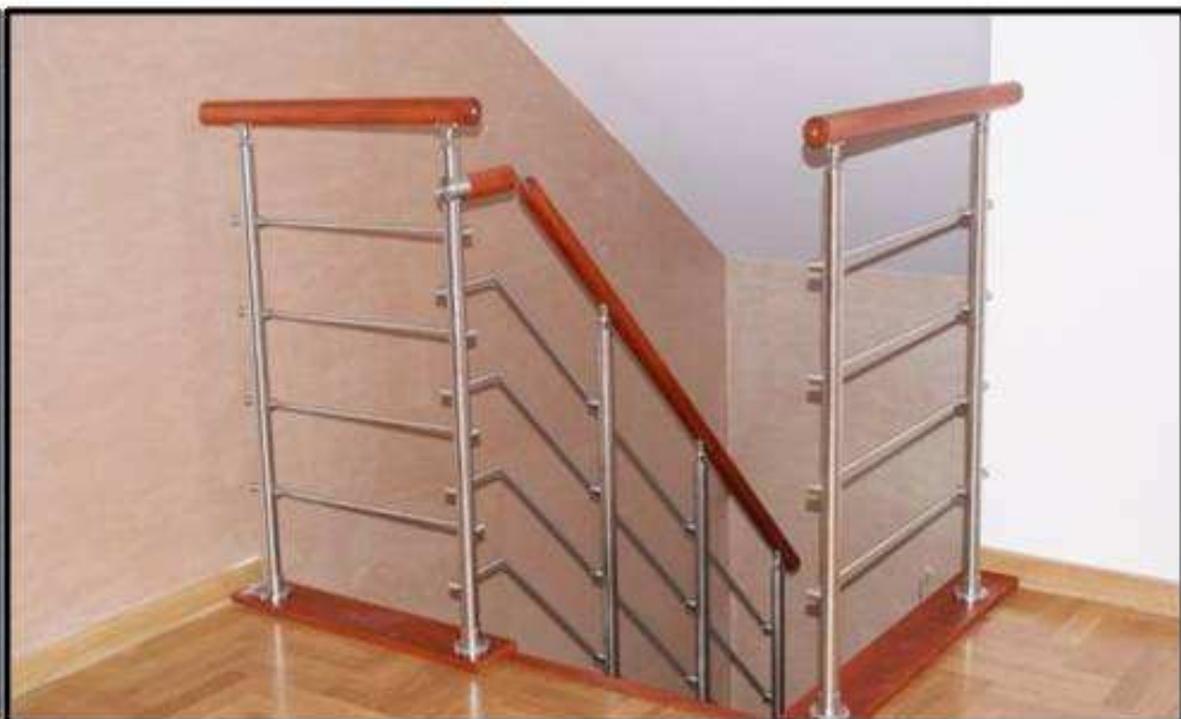
Balustrada ochronna otworu;
